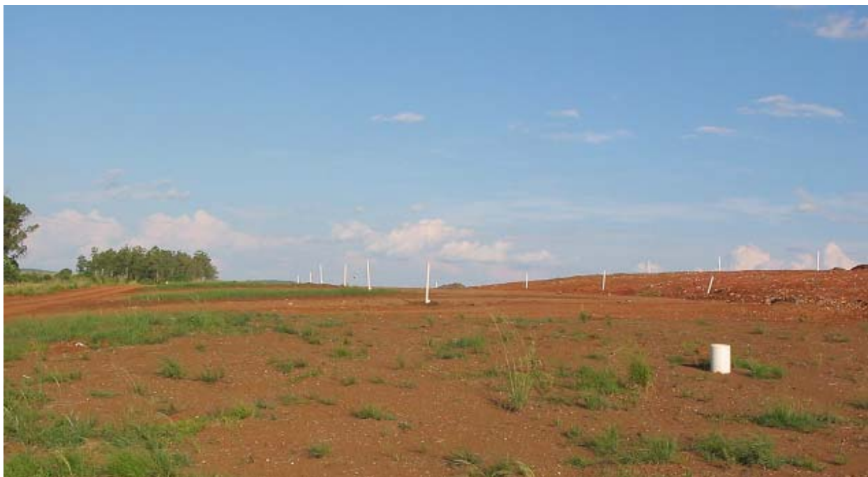
Figura 1: Vista del Relleno Sanitario Fachinal.
