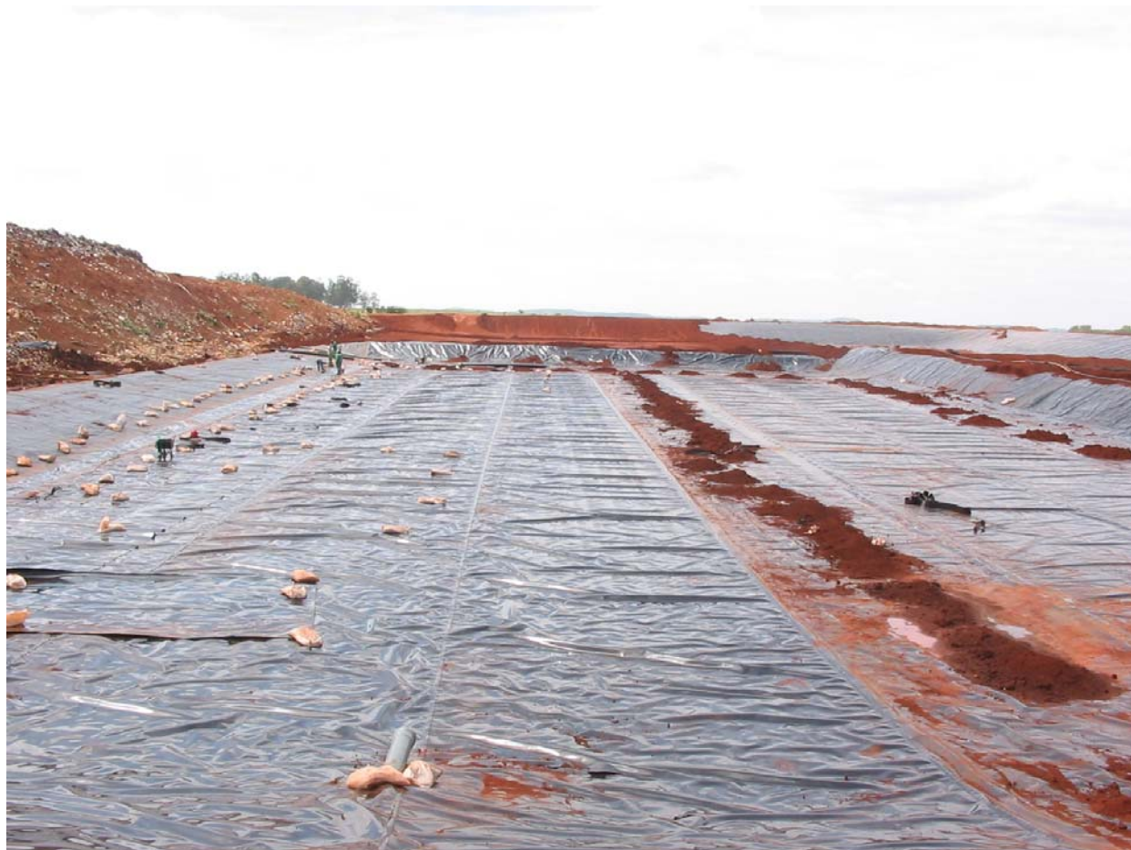
Figura 4: Instalación de Geomembrana en celda 3.
