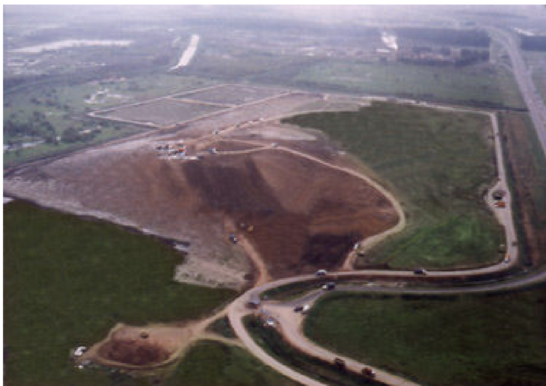
Figura 1. Foto aérea del Complejo Ambiental Norte III. 7
